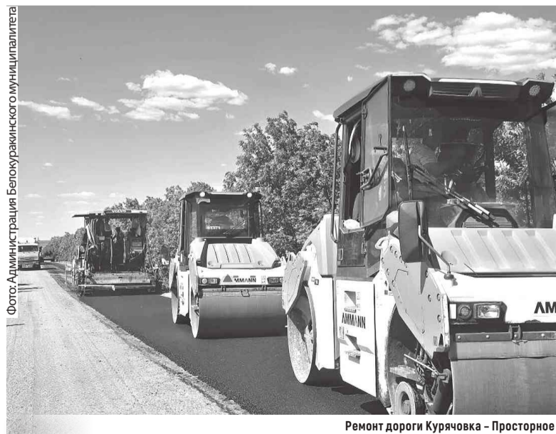
Ремонт дороги Курячовка – Просторное
