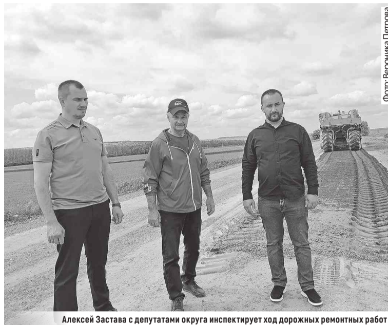
Алексей Застава с депутатами округа инспектирует ход дорожных ремонтных работ
