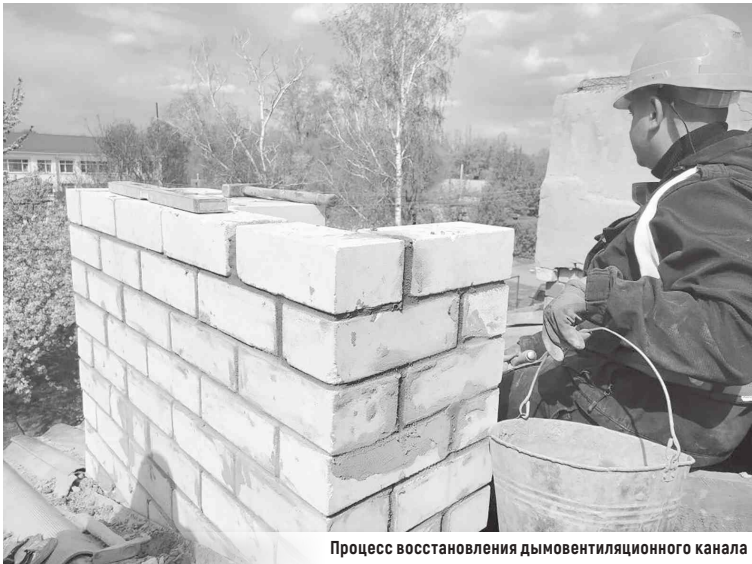
Процесс восстановления дымовентиляционного канала
