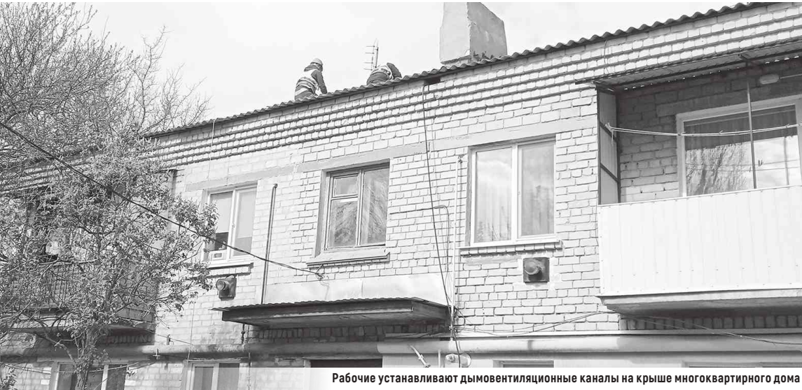
Рабочие устанавливают дымовентиляционные каналы на крыше многоквартирного дома
