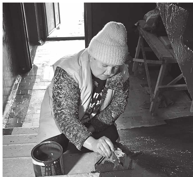
Маляр Наталья Ступарь ремонтирует второй подъезд дома № 9 микрорайона Молодежного
