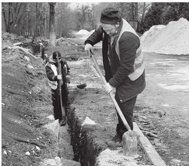
Строители готовят траншею для прокладки электрокабеля
