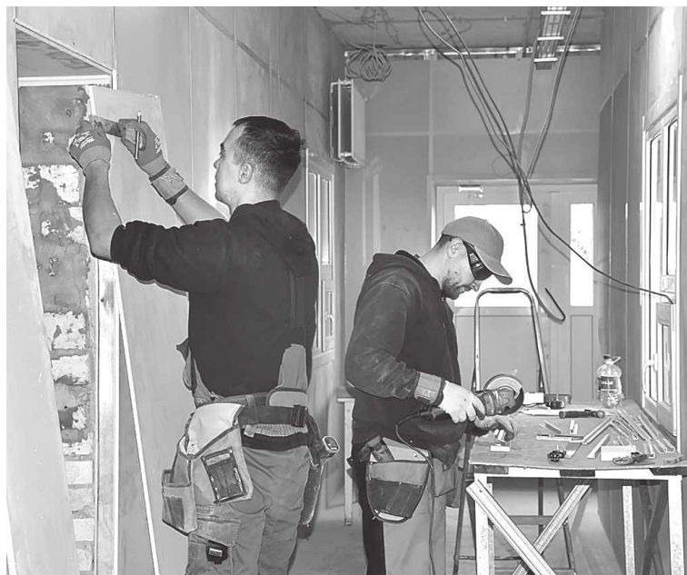
Отделочные работы в здании будущего инфекционного отделения
