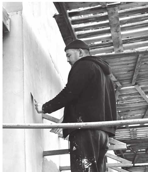
Строители штукатурят фасад АБК
