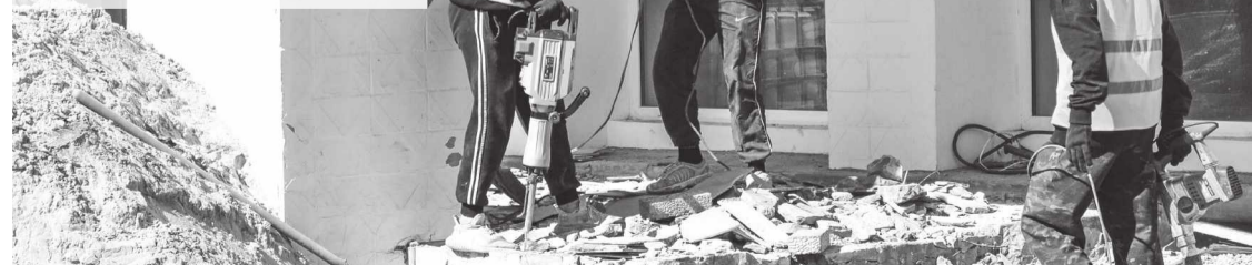
→ Проводятся демонтажные работы в Зимогорьевской школе
