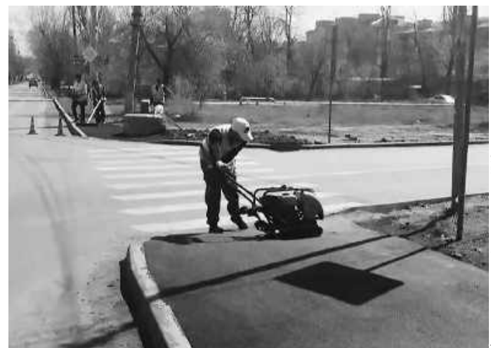
► Идет укладка асфальта на ул. Осо
