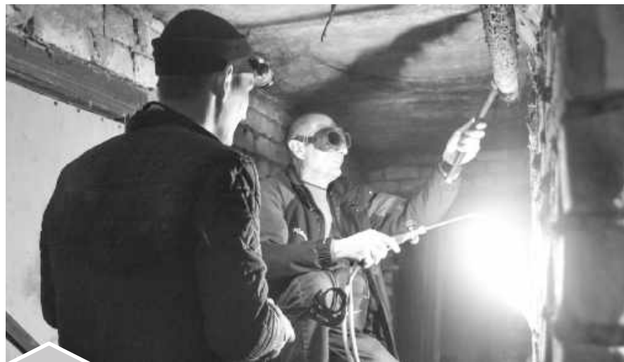
Сварщики восстановили систему водоснабжения в доме на улице Крупской
