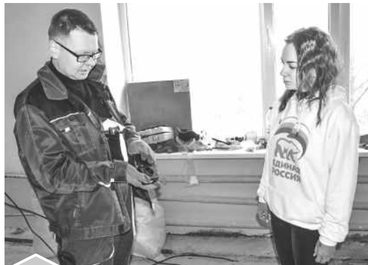
Представитель партии «Единая Россия» и подрядчик обсуждают замену системы электроснабжения в обновляемом классе
