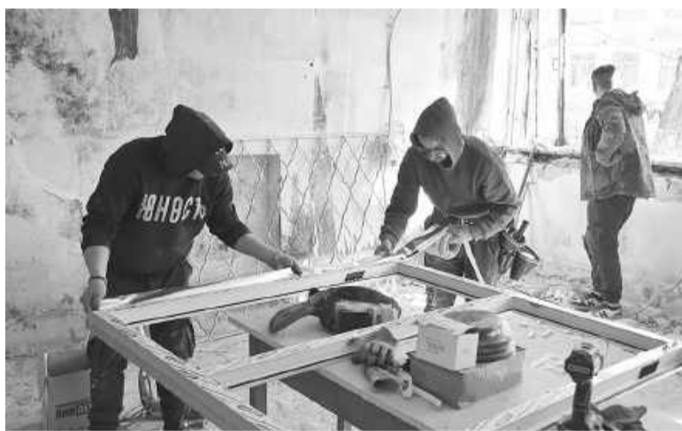
Специалисты осуществляют установку окон
