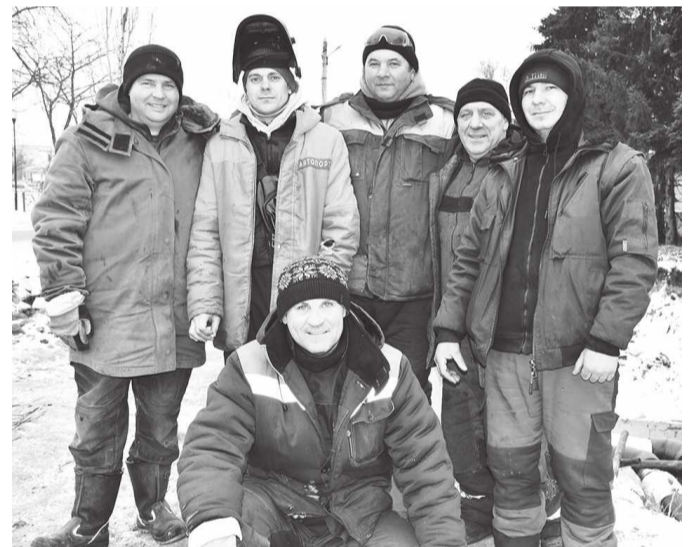
► Бригада укладчиков теплокоммуникаций
