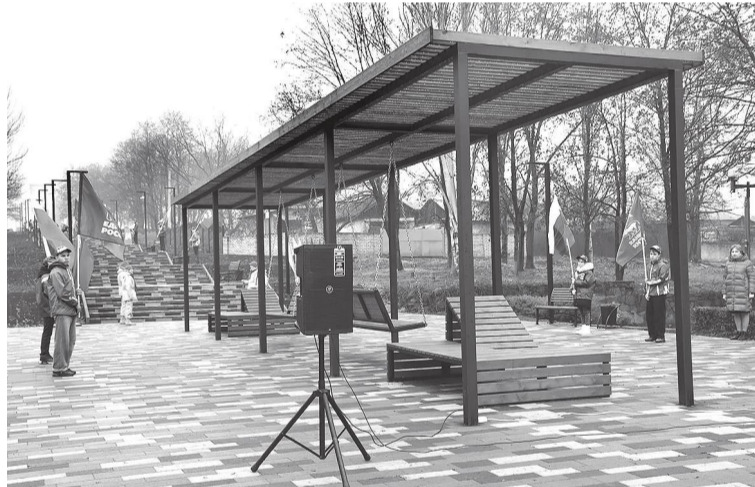
Площадка для отдыха у подножия каскадной лестницы
