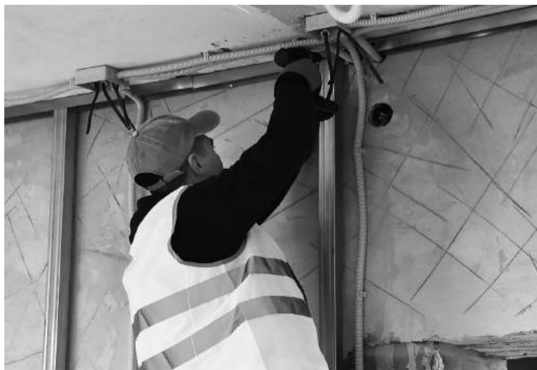
Монтаж каркаса для облицовки стен внутри инфекционного отделения
