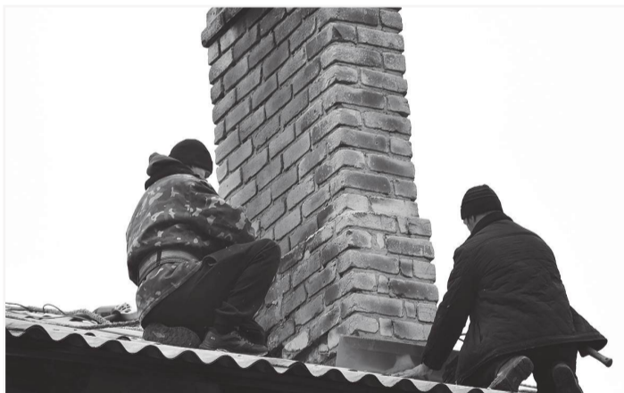
Ремонт кровли на доме № 57 на улице Молодогвардейской
