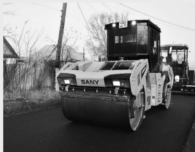
Ремонт дороги на улице Менжинского
