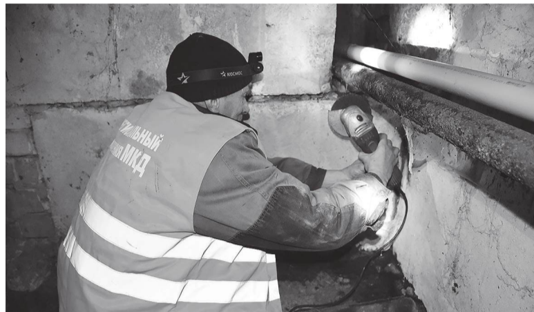
Замена внутридомовых систем холодного водоснабжения в подвале дома № 17 на улице Жуковского
