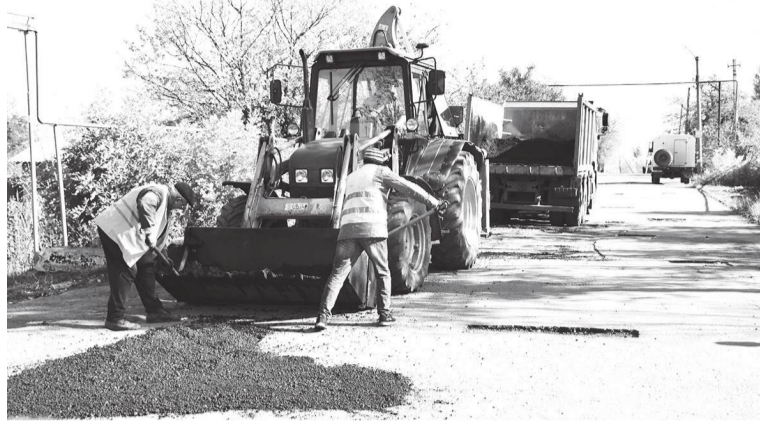
Приняв поздравления, брянковские дорожники продолжили ямочный ремонт дороги на улице Сурикова
