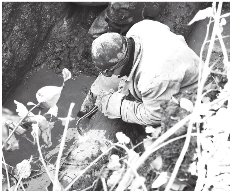
Устранение порыва на водоводе возле дома № 37 в микрорайоне № 4
