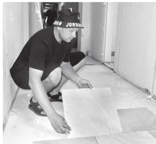
«В коридоре на полу будет уложена плитка», – рассказал прораб Сергей Королев.
