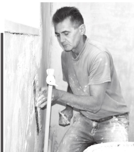
Евгений Косинов штукатурит стены
