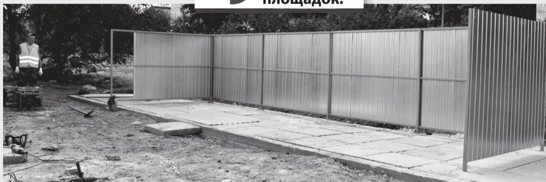
Благоустраивается контейнерная площадка в районе дома № 43 микрорайона № 4
