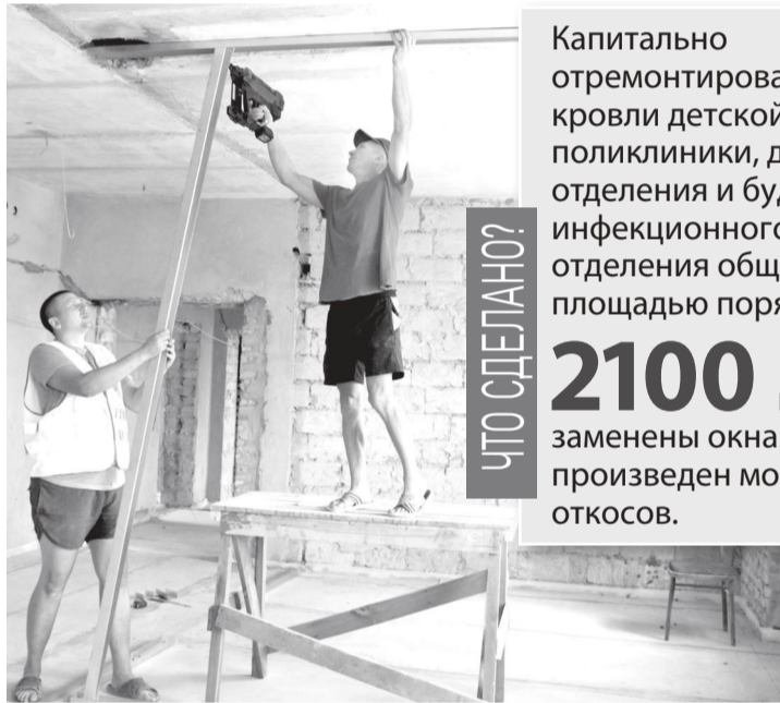
Строители из Брянской области ведут монтаж перегородок в здании будущего инфекционного отделения
