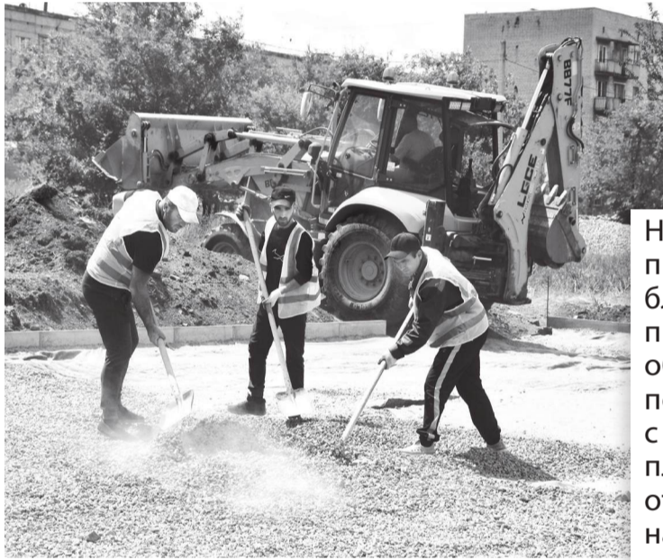
Ведется укладка основания для детской площадки
