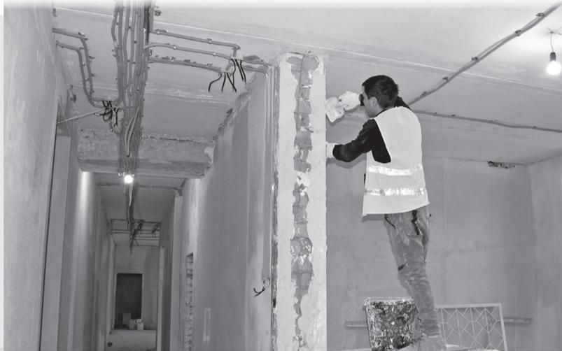
От привычного вида внутри музея не осталось буквально ничего. Стартовавшие в начале сентября ремонтные работы ведутся в ударном темпе: за полтора месяца специалисты уже провели демонтаж, возвели необходимые перегородки, выполнили стяжку полов. На данный момент заняты монтажом систем отопления и электричества.
