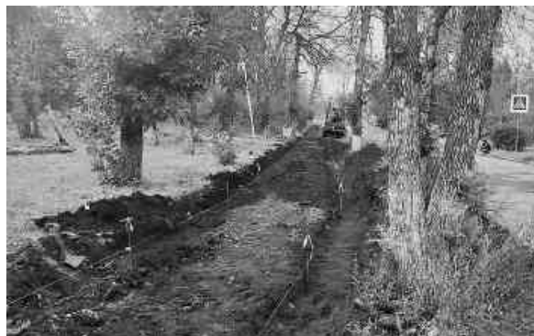
► Благоустройство пешеходной зоны
