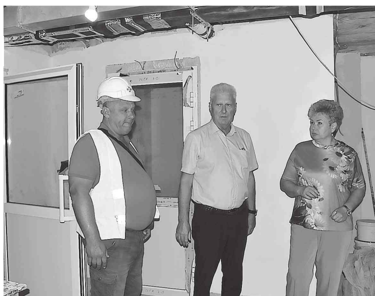
► Сенатор Ольга Бас ознакомилась с ходом ремонта внутренних помещений ЗАГСа
