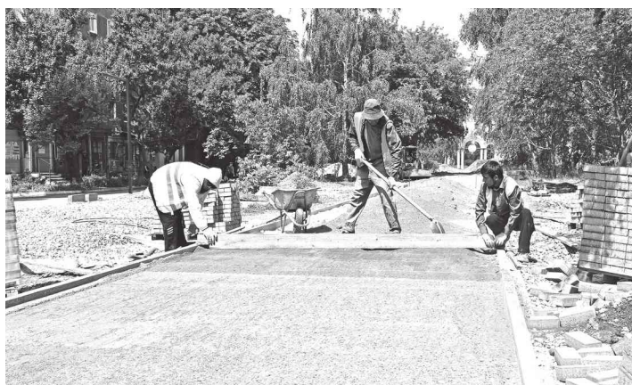
➤ Рабочие выполняют выравнивание цементно-песчаного слоя для дальнейшей укладки плитки
