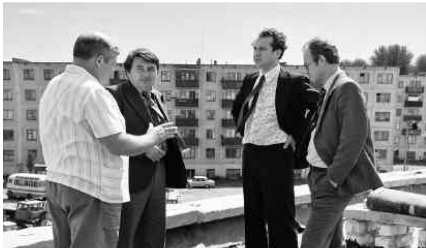
Виктор Мишин на строительстве СШ № 3, 1981 г.
