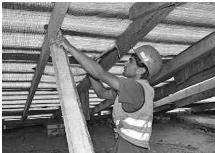
Капремонт кровли дома № 3 на улице Щетинина
