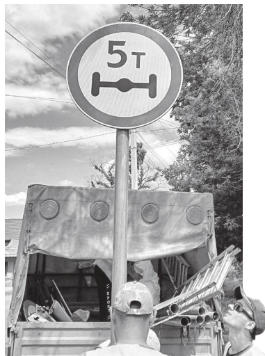
Сотрудники ООО «ПроектСтрой» устанавливают дорожные знаки
