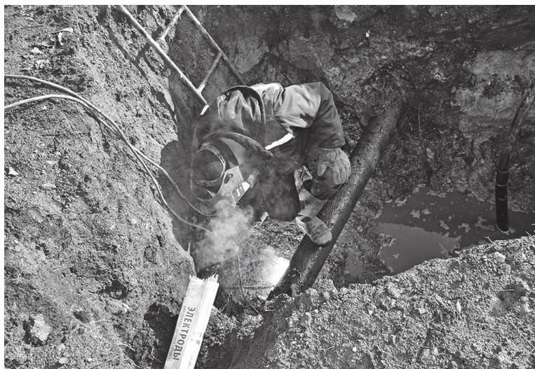
➤ Специалисты «Луганскводо» заменяют старую чугунную трубу на новый трубопровод диаметром 90 мм
