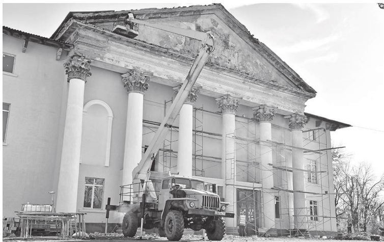
➤ Подрядной организацией ведутся работы по снятию старого покрытия и нанесению слоя штукатурки на лицевую часть клуба
