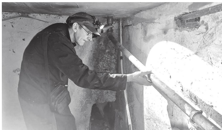
➤ Слесарь проводит демонтаж старого водопроводного стояка
