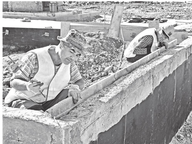
➤ Бетонные работы завершены на 90 %, а укладка тротуарной плитки – на 70 %
