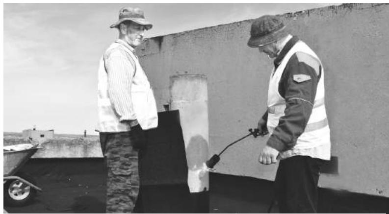
➤ Специалисты подрядной организации завершают кровельные работы на четвертом доме в квартале Центральном
