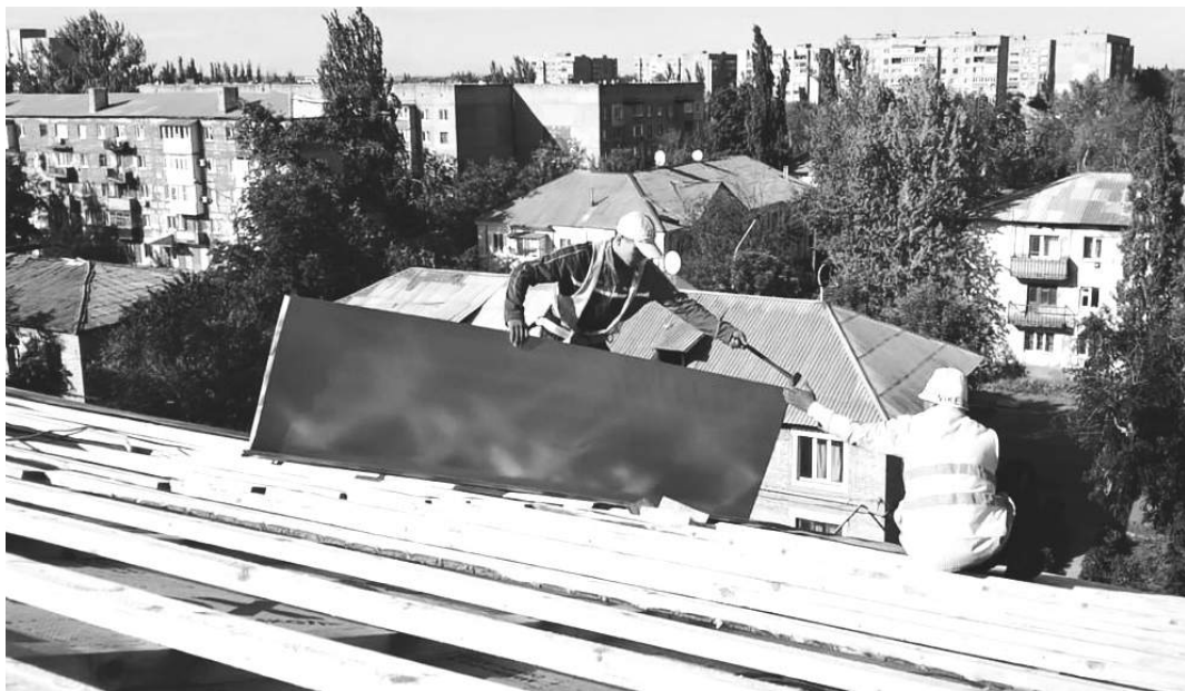
➤ Ремонт шиферной кровли на улице Ленина, 7 планируется завершить в сентябре текущего года
