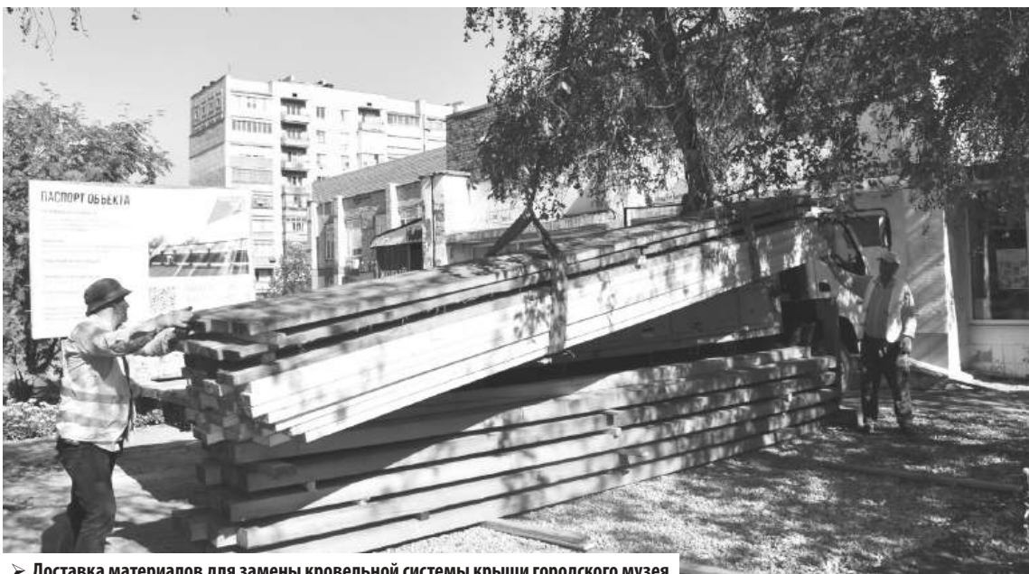
➤ Доставка материалов для замены кровельной системы крыши городского музея
