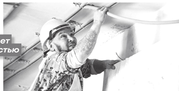
Подрядчики приступили к укладке новой электропроводки
