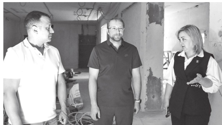
Министр культуры ЛНР и глава муниципалитета знакомятся с ходом ремонтных работ
