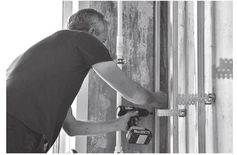
После демонтажа старых ветхих конструкций и покрытий в помещениях районной библиотеки рабочие начали следующий важный этап капитального ремонта. Они обработали стены и потолок специальными средствами от грибка и плесени, выполнили стяжку пола, монтируют гипсокартон, возводят новые стены.
