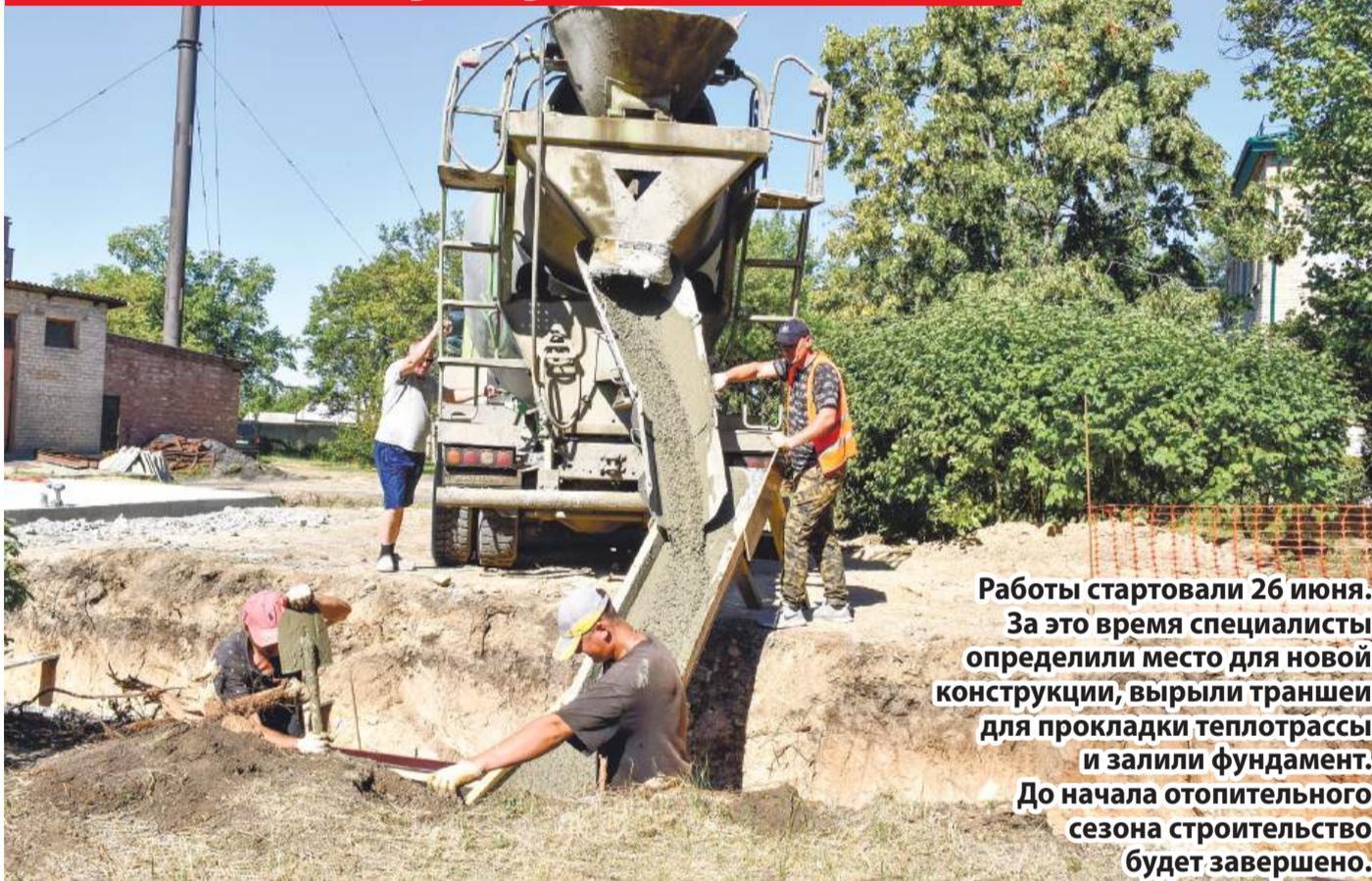
Работы стартовали 26 июня. За это время специалисты определили место для новой конструкции, вырыли траншеи для прокладки теплотрассы и залили фундамент. До начала отопительного сезона строительство будет завершено.
