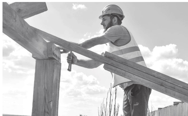
➤ Специалисты устанавливают стропильную систему кровли
