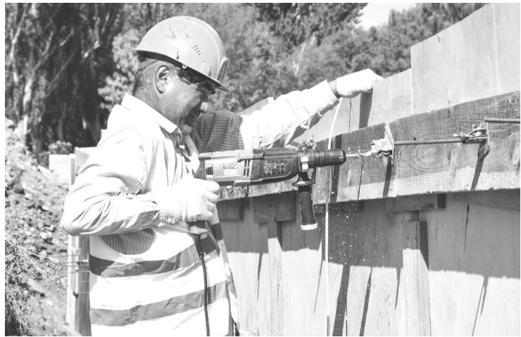
➤ Специалисты завершают бетонные работы по восстановлению монолитных стен
