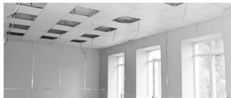
➤ В процессе капитальной перестройки находятся 33 помещения школы
