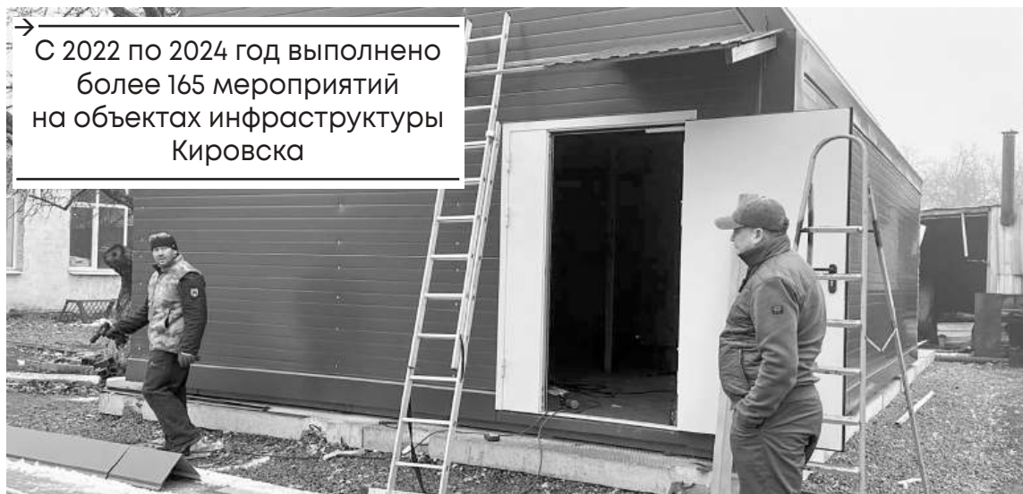
➤ Установка новой угольной блочно-модульной котельной позволила вернуть тепло в Кировский профессиональный колледж
