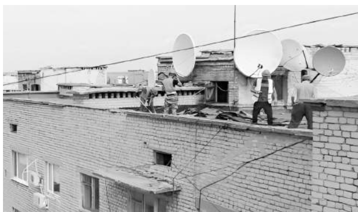
→ Специалисты подрядной организации проводят ремонтные работы на кровле дома № 5 по улице Погуляева
