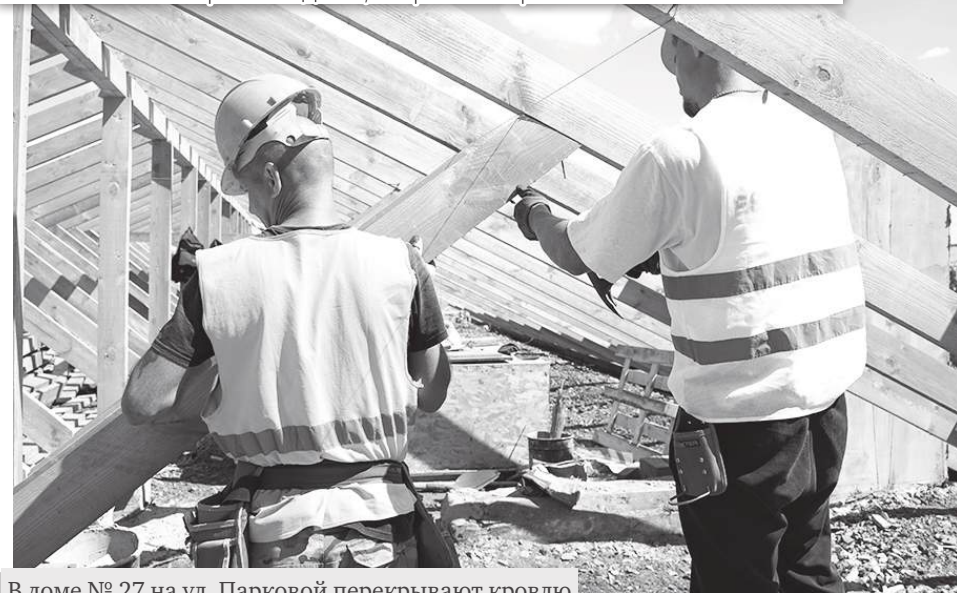
В доме № 27 на ул. Парковой перекрывают кровлю
