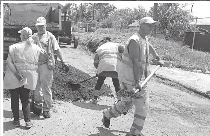
Ямочный ремонт дороги на участке ул. Петровского – ул. Московская
