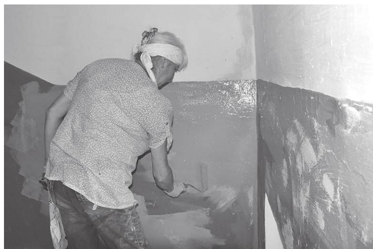
Ремонт подъезда дома № 16 на ул. Петровского вскоре завершится
