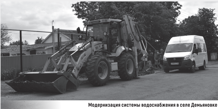
Модернизация системы водоснабжения в селе Демьяновке
