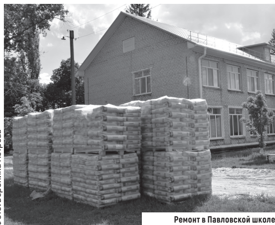
Ремонт в Павловской школе
