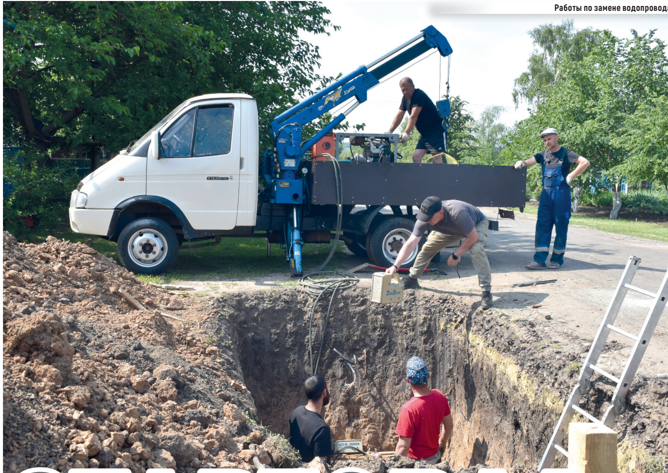
Работы по замене водопровода
