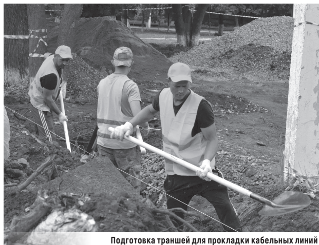
Подготовка траншей для прокладки кабельных линий
