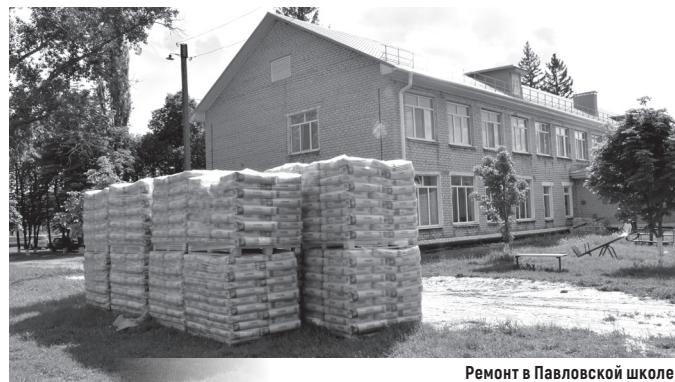
Ремонт в Павловской школе
