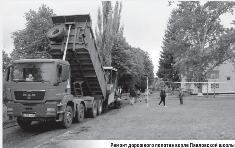
Ремонт дорожного полотна возле Павловской школы
