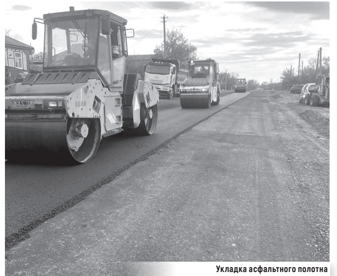
Укладка асфальтного полотна
