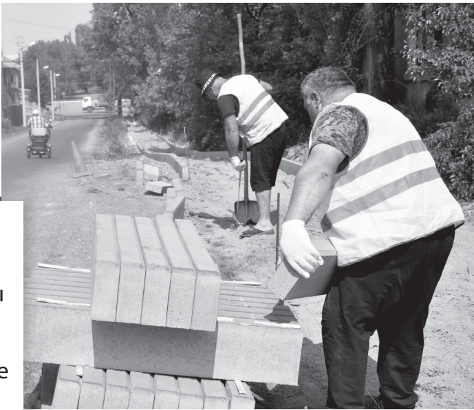
Ведется укладка бордюра на улице Маяковского
