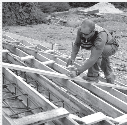
Восстановление ступеней каскадной лестницы
