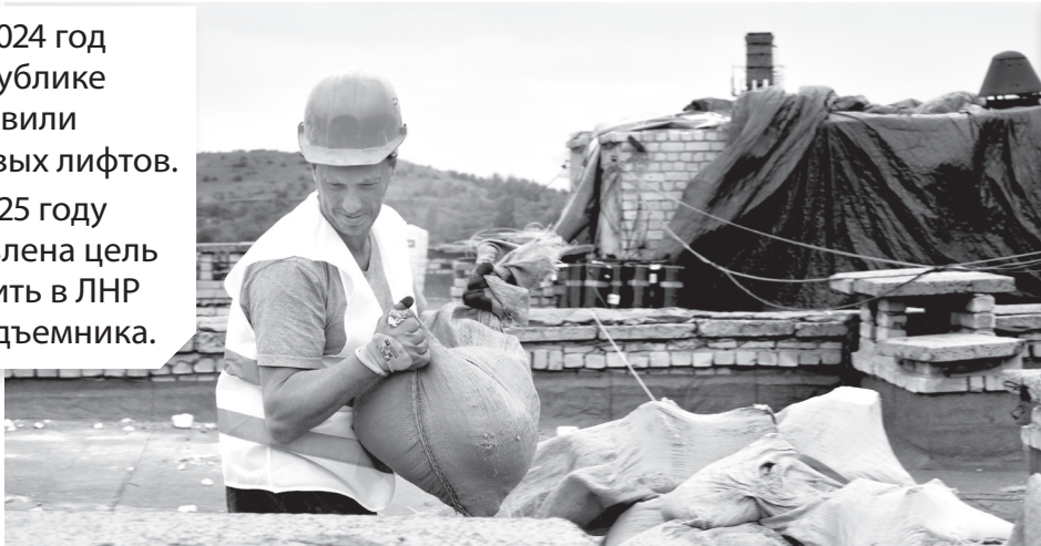
Капремонт кровли на доме № 1 в микрорайоне Молодежном
