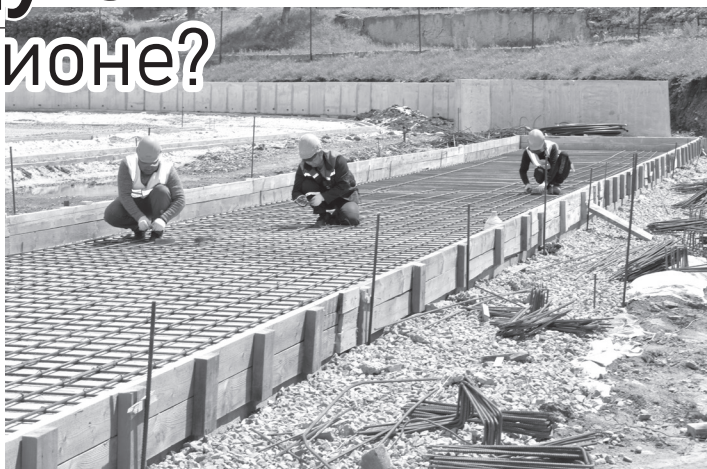
Обустройство опалубки под трибуну
