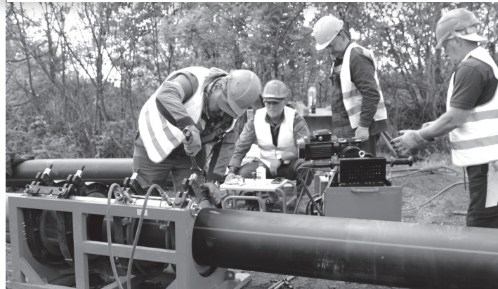
Ведется пайка трубы в рамках реконструкции напорного коллектора КНС «Северная»
