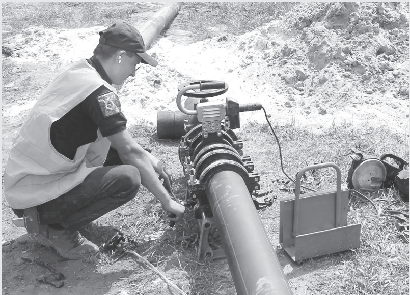
Замена аварийного участка водовода ВНС «Криворожская» – «Подключение ЦГБ»
