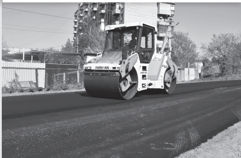
Ремонт дороги на улице Саксаганского
