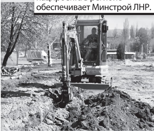
Ведутся работы на площадке у подножия лестницы
