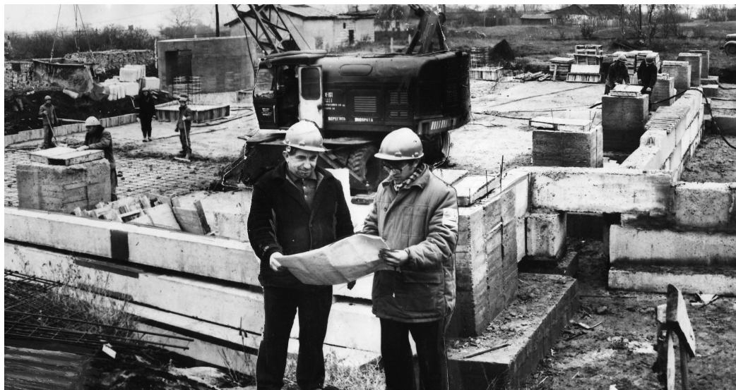
Работники хозрасчетного участка возводят газовую котельную
